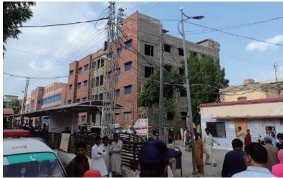
建設中のPICU棟（横幅30m×奥行20m）
