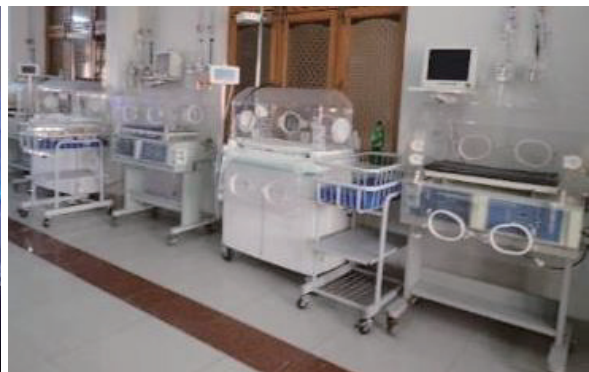
閉鎖型保育器：正常に稼働している。
