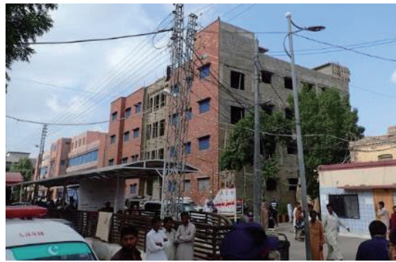
写真6 LUH/ハイデラバード分院 建設中の小児病棟。
