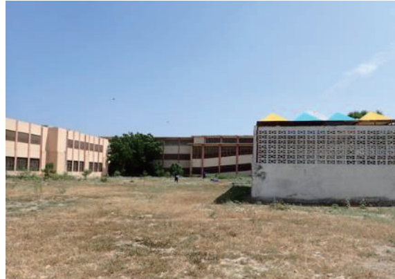
写真2 計画敷地 建設用地として十分な広さを持つ。右手建物は先方負担で解体される。
