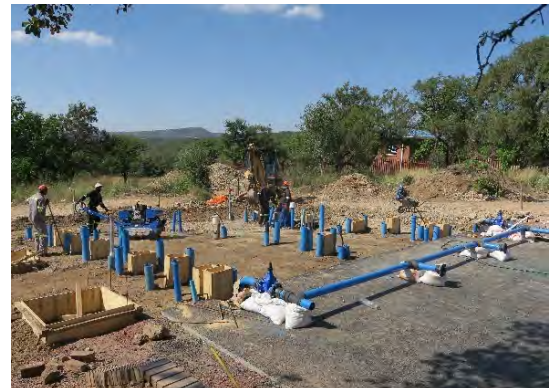
写真 104 ヤード建設工事 (埋め戻し後)
