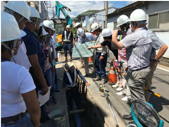
写真 123 第 2 回本邦研修 (横浜市水道工事現場視察)
