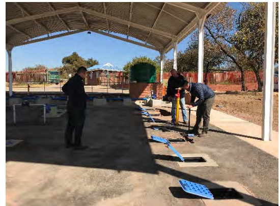
写真 110 研修ヤード（漏水箇所特定）
