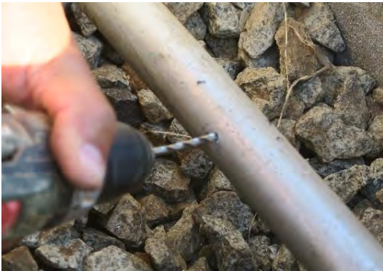
写真 101 ヤード建設工事 (鋼管-人工漏水孔)
