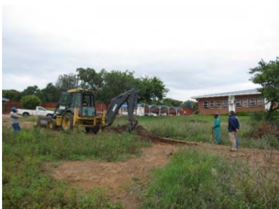
写真 27 研修ヤード候補地での既存敷設管の確認
