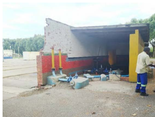
写真 24 KZN 州 eThekweni 市配管訓練ヤード
