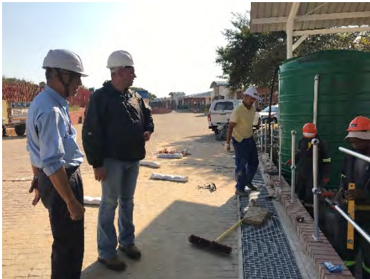
写真 107 研修ヤード施工監理
