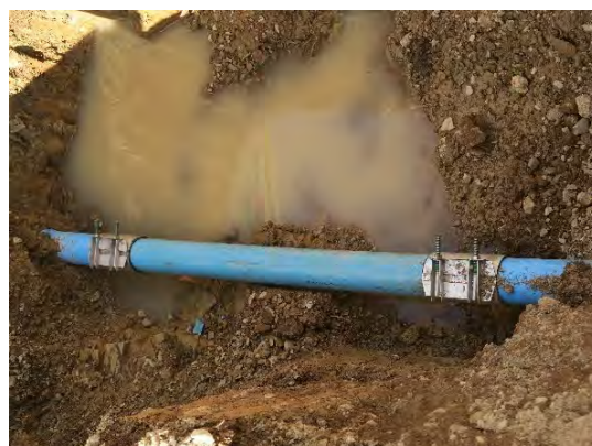
写真 38 配管破裂補修現場 (Tshwane 市)
