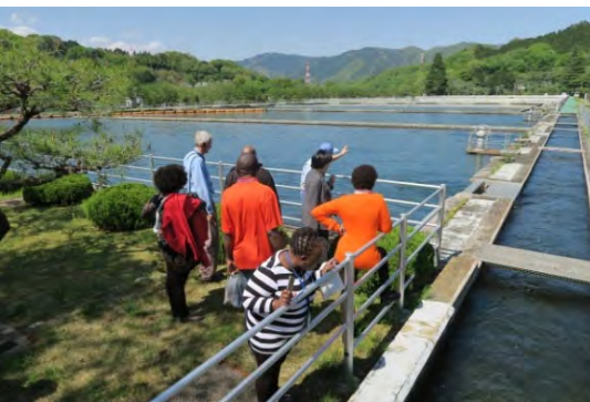
写真 55 第 1 回本邦研修（横浜市青山水源事務所／沈澱池）
