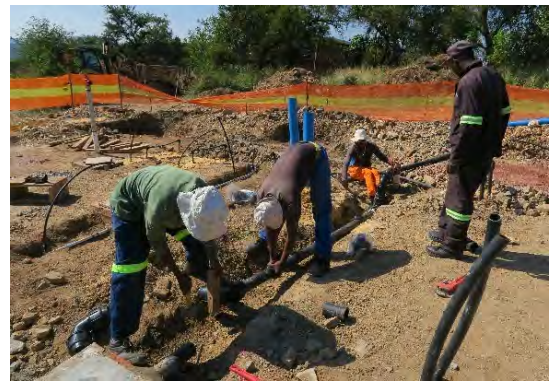
写真 102 ヤード建設工事 (HDPE 埋設管敷設)
