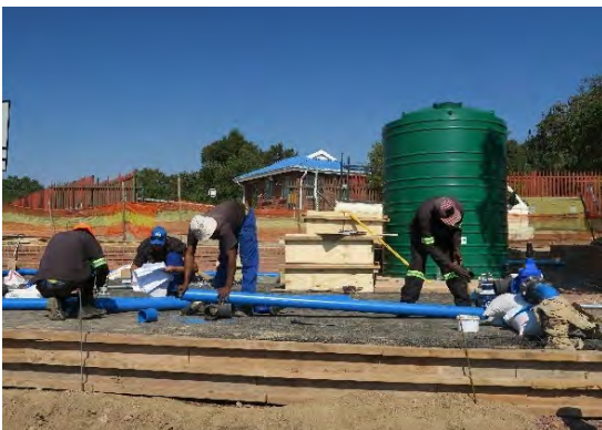
写真 103 ヤード建設工事 (uPVC 露出管敷設)
