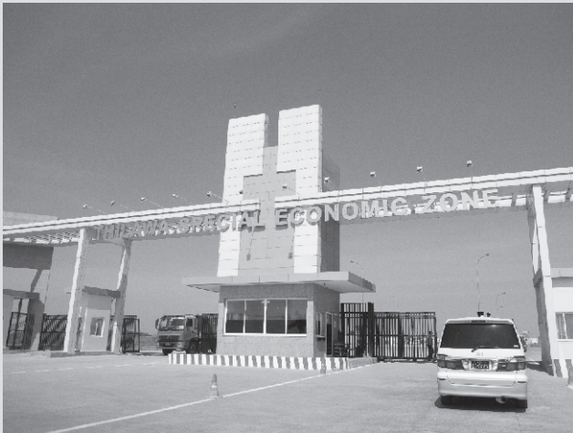
Myanmar: Una entrada a la zona económica especial bajo desarrollo en el área de Thilawa, cerca de Yangon. JICA apoya a la empresa que desarrolla y administra el parque industrial bajo el programa de Financiamiento a las inversiones por la iniciativa privada, apoyando así el desarrollo económico de Myanmar por medio de la Asociación Público-Privada. (Fotografía por Shinichi Kuno)
