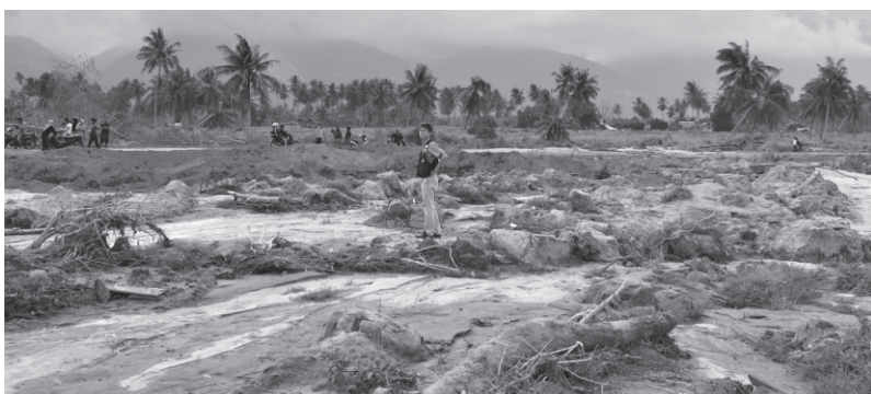
Licuefacción causada por el terremoto en la ciudad de Palu
