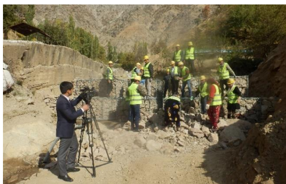
施工状況の撮影
