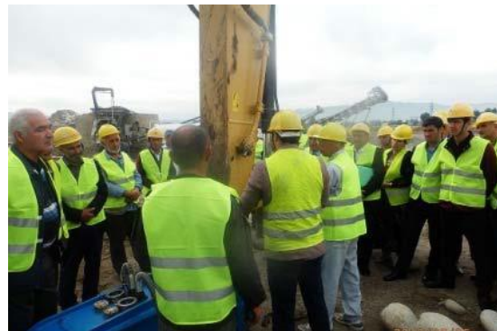
ロックブレイカーを用いた現場研修
