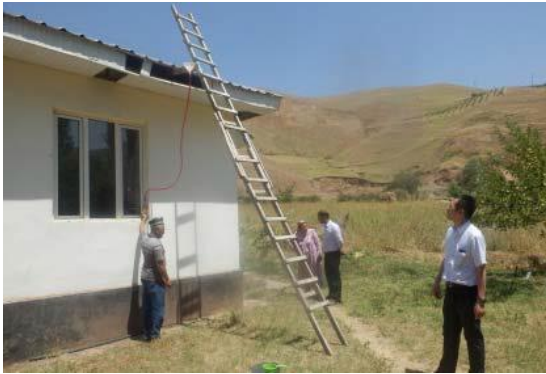
早期警戒用システムの設置
