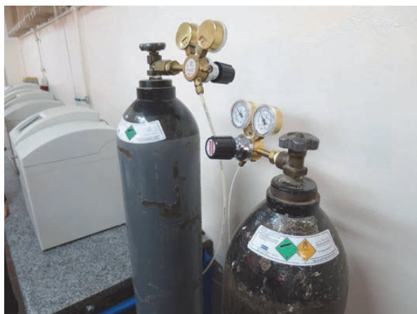
写真 2.3-33 窒素ガスの設置状況
