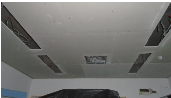
天井捨貼りボード
