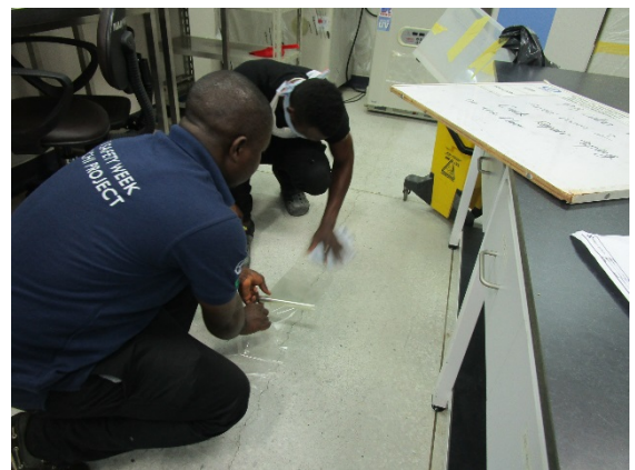
補修用保護フィルム張り作業中
