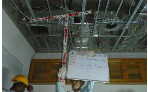
天井 LGS 下地確認
