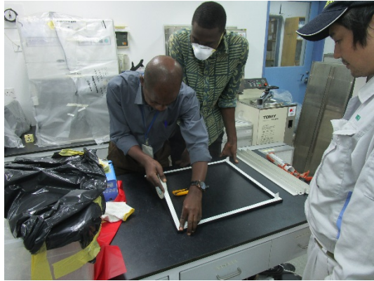
HEPA フィルター交換
