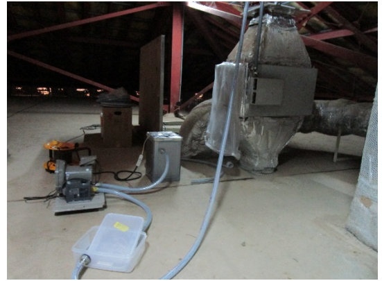
天井裏排気ダクト内燻蒸
