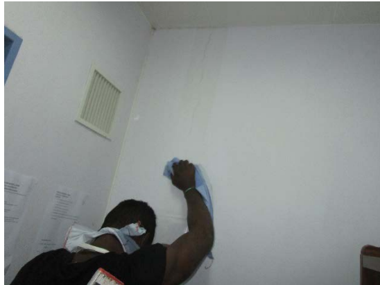
補修用保護フィルム張り作業中
