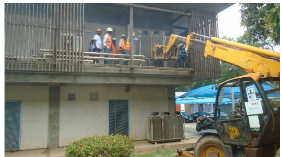
チラー交換作業
