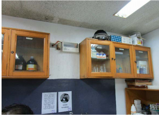
天井張替え前
