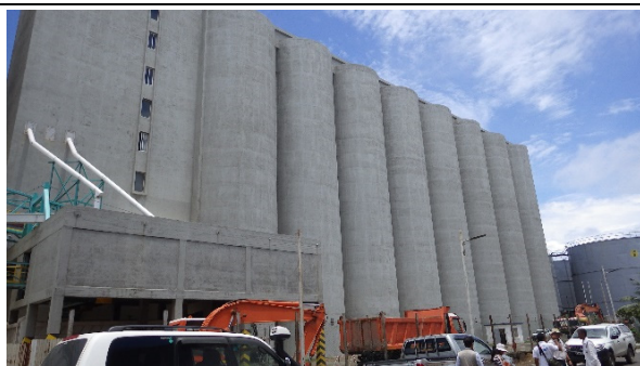
23) Silo à farine importée du port de Toamasina. Ce n'est pas un entrepôt climatisé pour l'exportation de riz, et la mise en place d'un système de climatisation est nécessaire pour l'exportation du riz. Entré en service en octobre 2019. District de Toamasina I, région d'Atsinanana.
