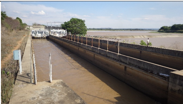
18) Vue du barrage du périmètre irrigué de Dabara alimenté à partir du fleuve Morondava. Surface irriguée totale de 12.000 ha. La DRAEP s'occupe de l'opération des vannes de prise d'eau, et l'association d'usagers de l'eau exploite et entretient les canaux au-dessous des canaux primaires. District de Mahabo, région de Menabe.
