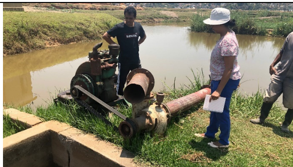
19) Motopompe opérée par les Groupements de producteurs semenciers (GPS). Cette méthode d'irrigation est rare. District d'Amabohitrtrimo, région d'Analamanga.
