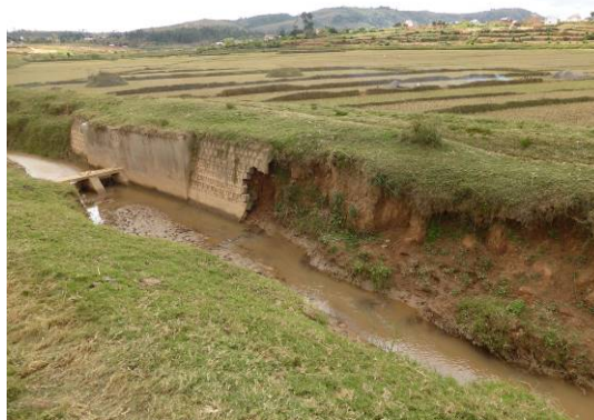
Périmètres irrigués d'Ambatolampy Tsimahafotsy, banlieue d'Antananarivo
