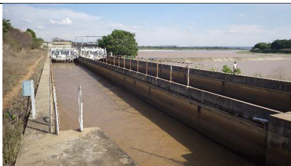
18) 大規模河川 Morondova 川から取水する Dabara 灌漑地区頭首工の様子。総灌漑面積は 12,000ha に及ぶ。取水ゲートの操作は DRAEP が行うが、一次幹線水路以下は水利組合が運用・維持管理を行う Menabe 県 Mahabo 郡。
