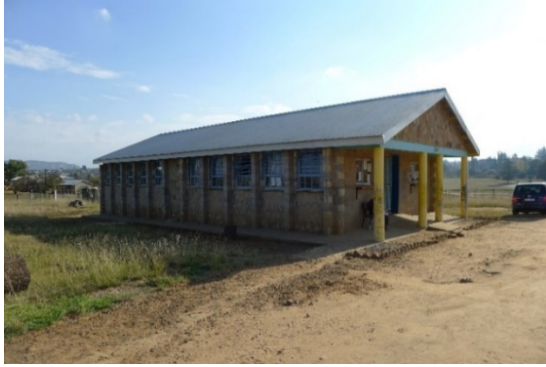
対象教職員棟南側全景
