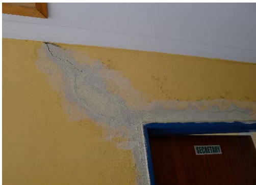
不具合の状況: 対象校による補修。その後はクラックなし
