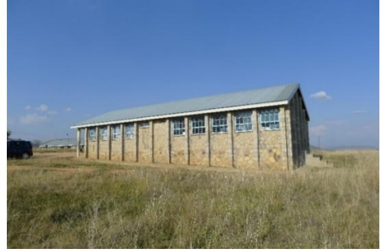
対象教職員棟北側全景
