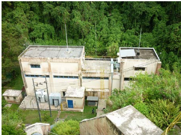
発電所建屋（ヘッドタンクより眺める） （鉄筋コンクリート構造 2 階建て建屋、2009 年に増設した。）
