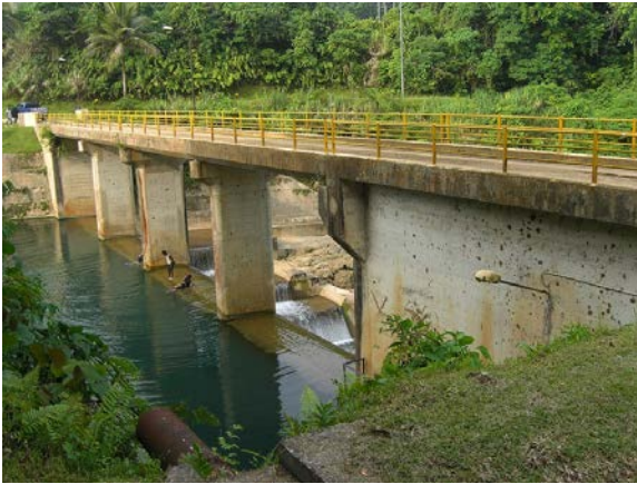
取水堰堤（上流右岸より）
