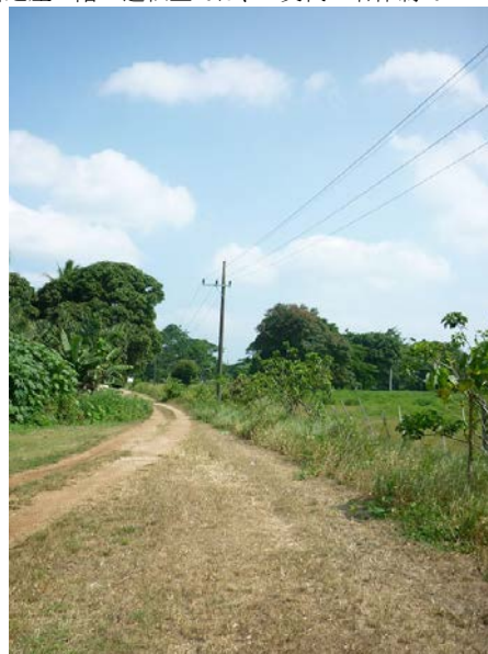
既設 20 kV 送電線 （既設サラカタ川水力発電所から市内のルーガンビル変電所まで延長約 20km の送電線は道路沿いに建設された）
