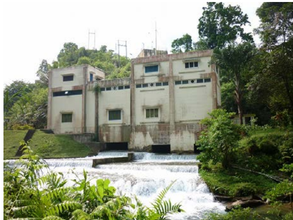
発電所建屋及び放水口（左岸対岸より眺める） （右から 1、2、3 号機の放水口であり、放水庭となっている）
