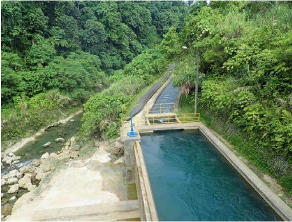
沈砂池（取水堰堤より下流を眺める）
