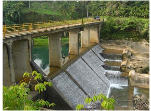
取水堰堤（下流右岸より）
