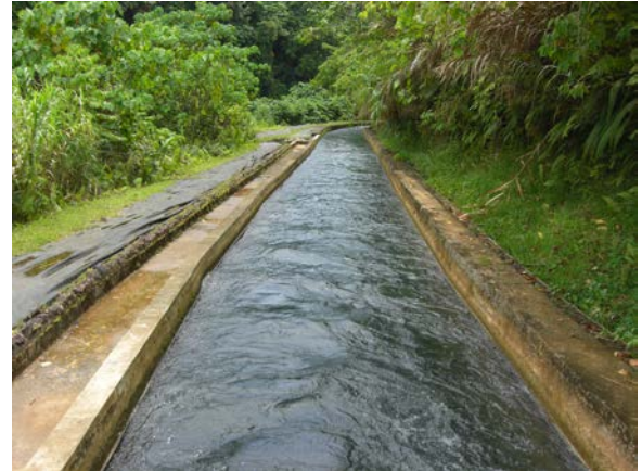
導水路（開水路）
