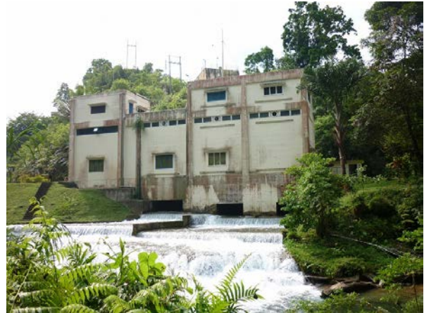
発電所建屋及び放水口（左岸対岸より眺める） （右から1、2、3号機の放水口であり、放水庭となっている）
