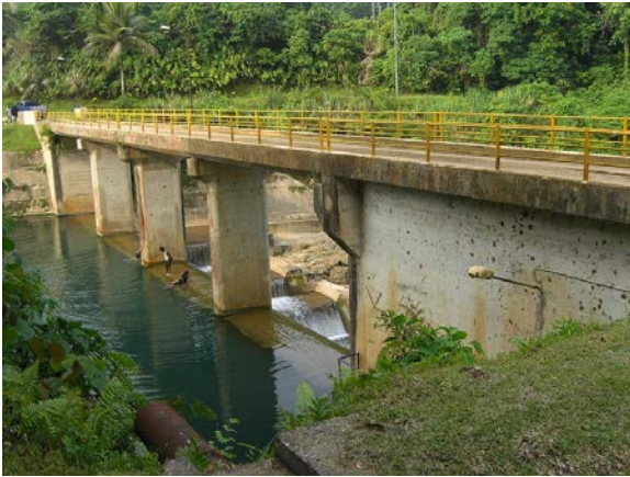
取水堰堤（上流右岸より）
