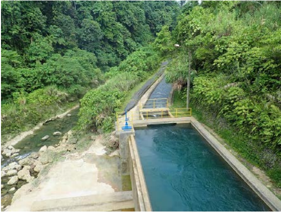
沈砂池（取水堰堤より下流を眺める）
