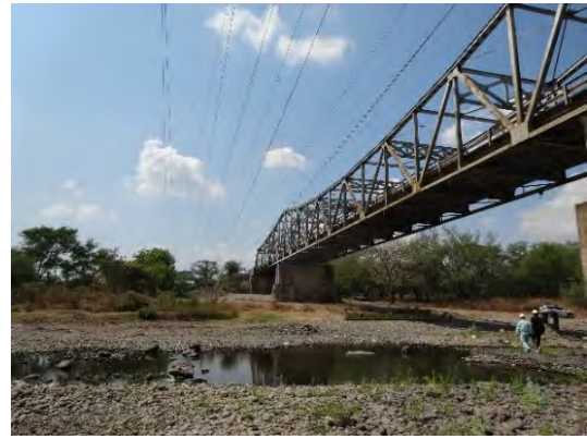
写真-8: 下流左岸から
