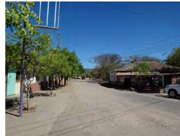
T05：左岸上流側取付道路 幅員約 5m 未舗装道路 (INVEST-H の将来舗装計画を予定)
