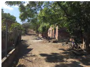
T04：右岸下流側取付道路 幅員約 5m 未舗装道路
