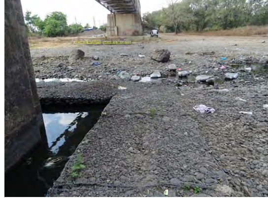
写真-14: 既存 P1 橋脚近景 (蛇籠による洗堀防護)
