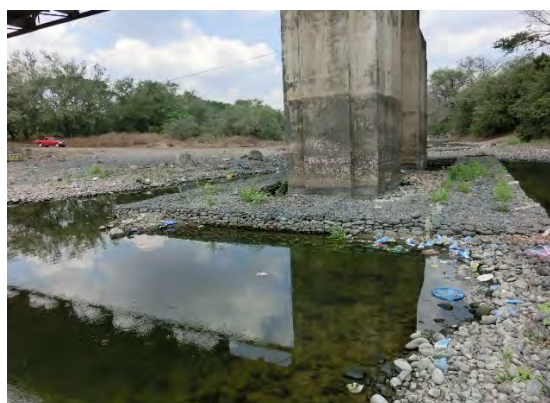
図 3.2.19 既存橋左岸側橋脚河床部写真
