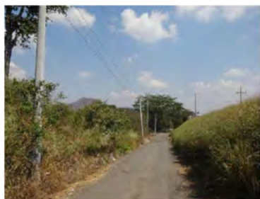
T03：右岸上流側取付道路 幅員約 5m 舗装済み道路
