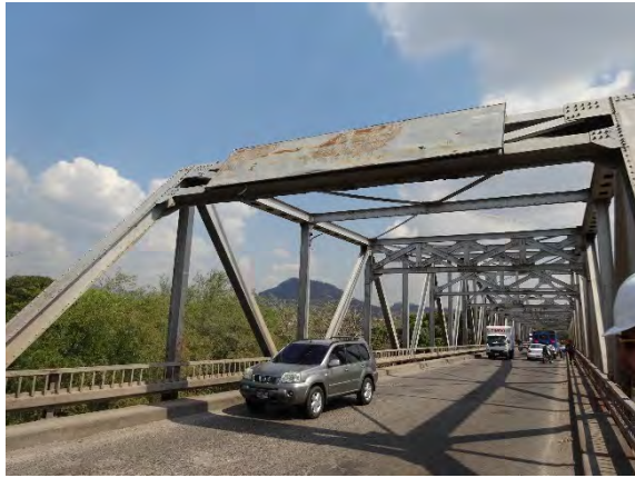
写真-1:橋梁上から Cholteca (東) 方向
