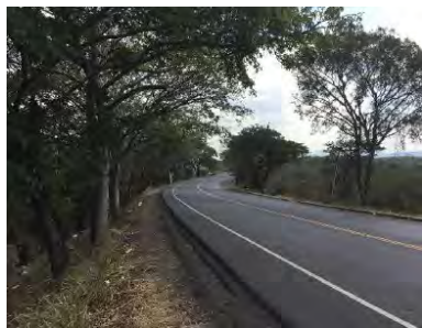
T01：左岸側線形 現況道路曲線半径約 425m
