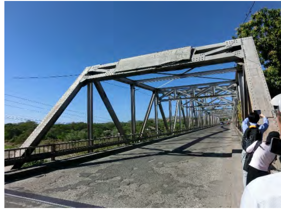
写真-2:橋梁上から El Estero (西) 方向
