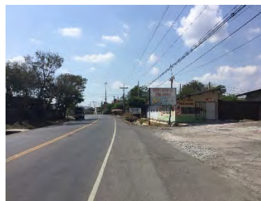
T01：右岸側線形 現況の道路曲線半径約 580m
