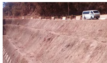
立入防止テープ設置状況
