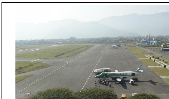
写真 3.2-4 既存エプロン全景
