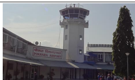
写真 3.2-5 旅客ターミナルビル・管制塔
