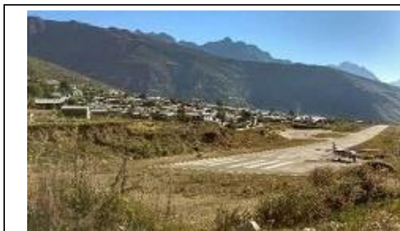
写真 3.3-14 空港滑走路全景
