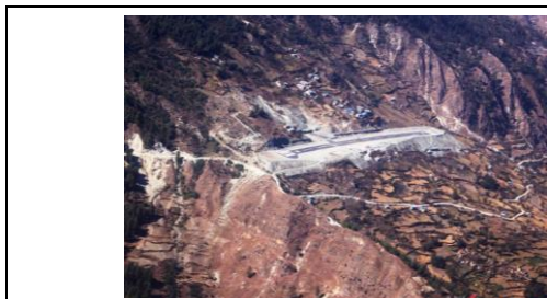
写真 3.3-29 空港滑走路全景
