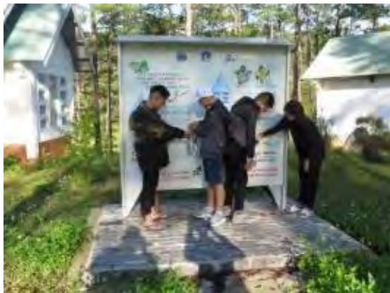
LB-BRの恵みである天然水を供給する 給水施設 (2020年6月9日)
