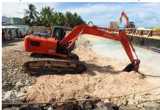
(投入した砂の均し作業)
