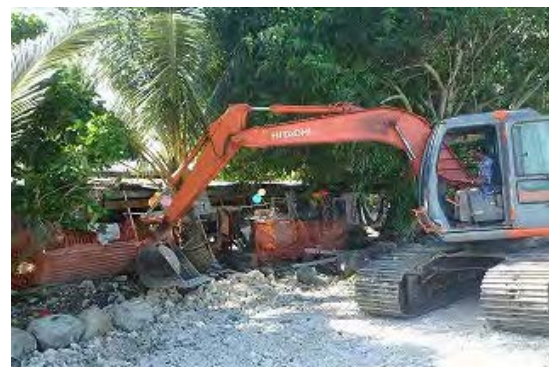
(後浜石の設置)
