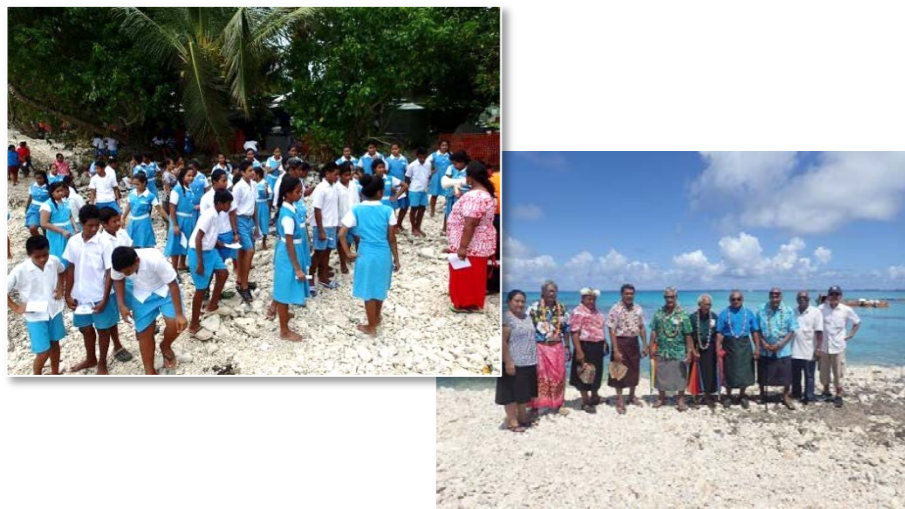
海岸見学ツアー(施工中)
