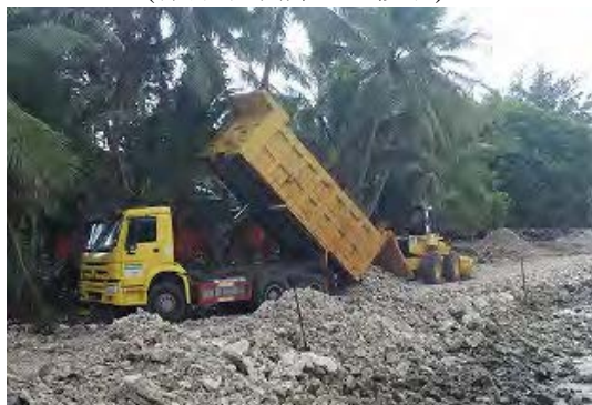
(建設現場での礫の投入)
