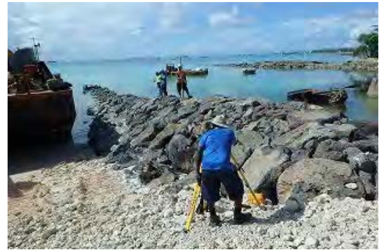
(突堤の断面検査)
