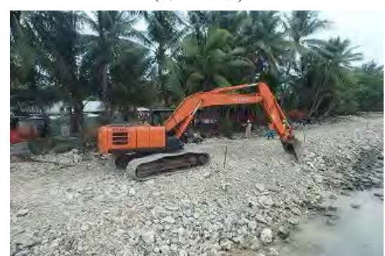
(投入した礫の均し作業)
