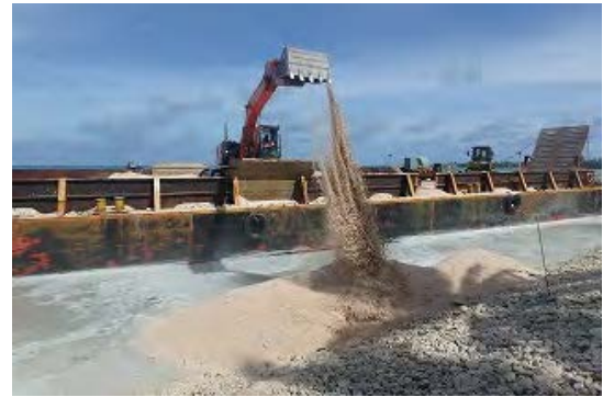
(建設現場への砂の投入)
