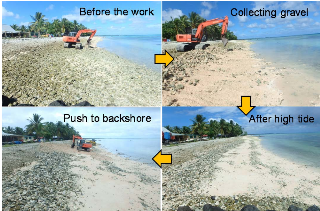
図 13.9 バックホーを用いた礫の収集および投入 (ステップ 1)
