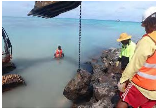
(突堤の被覆石の設置) (フジーより調達)
