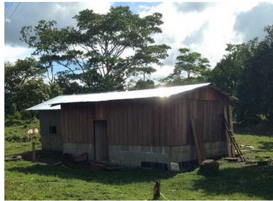
Casa Base construida por iniciativa de la población
