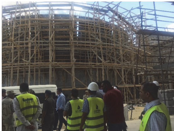
新キャンパスの建設状況 (2018年9月)
