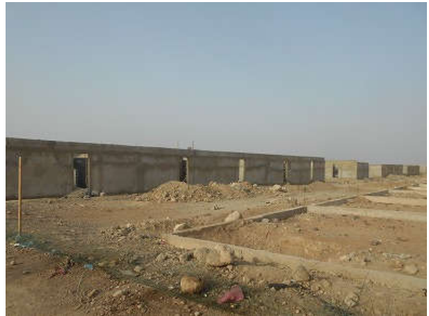
写真 7:。建設中の住宅。平屋、連棟式で低コストの建設を目指したユニットの開発が行われている。
