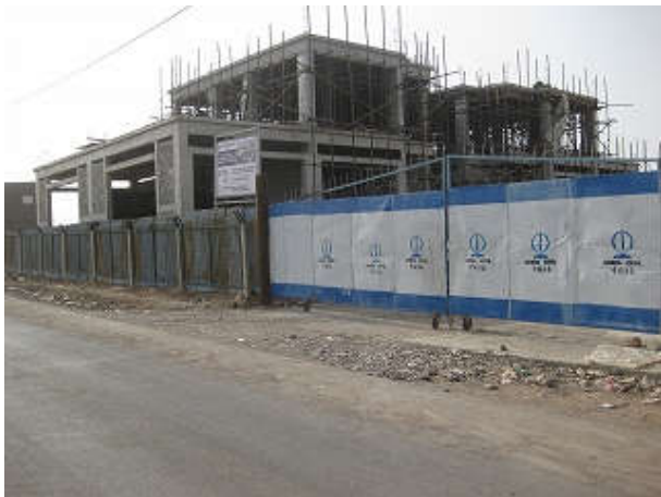
写真 8: 建設中のモスク、住居、業務施設を含む複合施設。都市計画に沿った近隣施設の建設も進められている。
