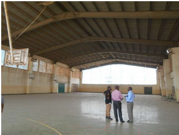
写真 3:Fukuzawa 中学校体育館。欄間と妻面が開放された簡易な構造。
