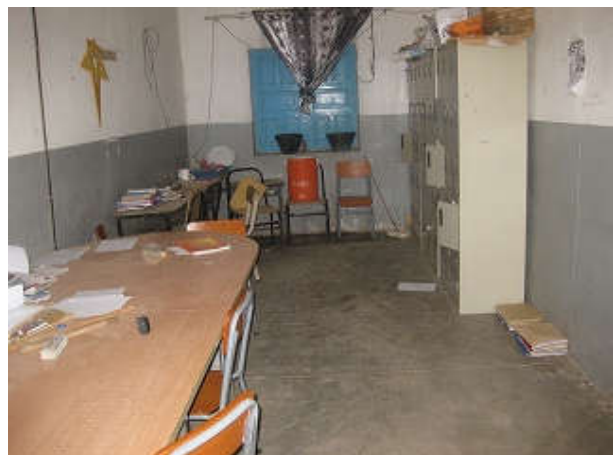
写真 18: Biokeyd 中学校教員室兼事務室。中学校運営に必要な事務管理用諸室がないため、倉庫を教員室、事務室として利用している。
