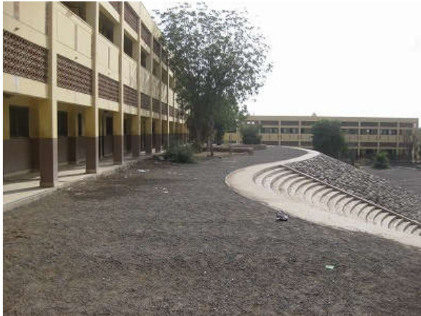
写真 1:Fukuzawa 中学校。日本の無償資金協力により1995年にバルバラ地区で初めて建設された中学校。フルコンポーネントの施設を備えた中学校のモデルとなっている。
