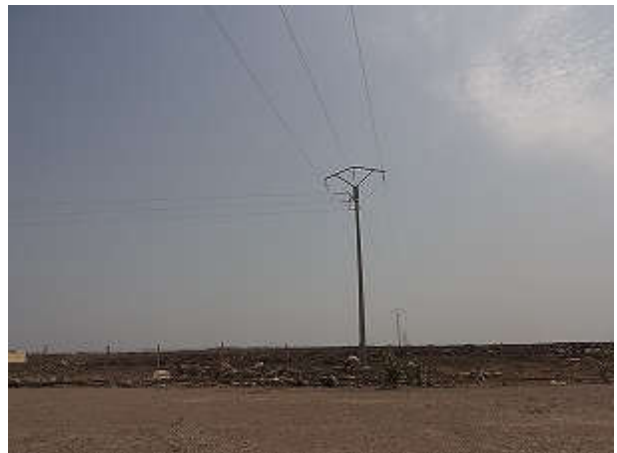
写真 5: 計画地の西側約150mに EDD の中圧配電網が通っており、Nassib 地区の既存住宅地へは世銀プロジェクトによる低圧配電網が設置されている。
