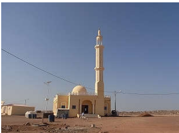
写真 10: 建設済みのモスク。
