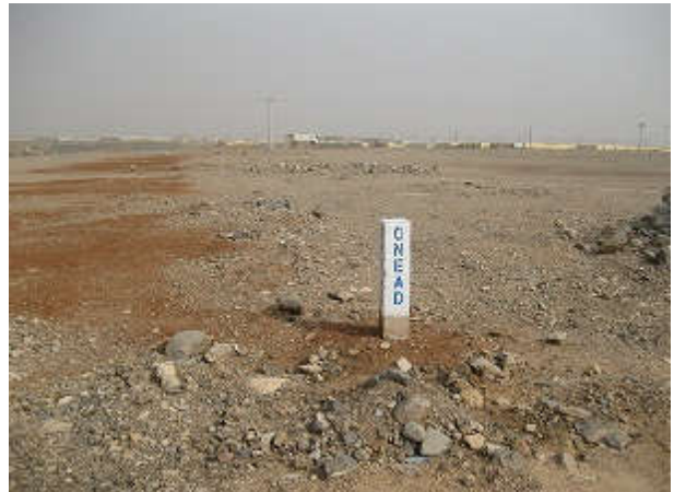
写真 3: 敷地北側の計画道路に埋設された ONEAD の給水本管(150φ)位置を示す標柱。敷地北西端に位置する。
