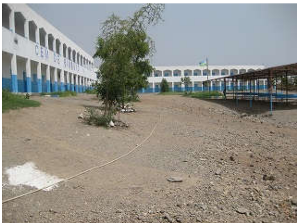
写真 17: Biokeyd 中学校外観。小学校標準設計による校舎。右手校庭に世銀支援により生徒が空き時間を過ごすためのシェルターが建設されている。
