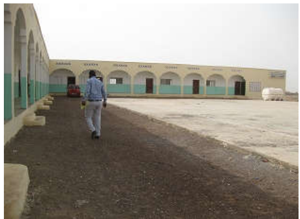
写真 11: ナッシブ幼稚園。地区最初の小学校として 1 年間利用されたが、Nassib 小学校の完成後は幼稚園として利用されている。
