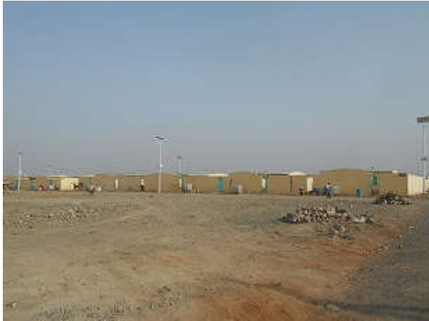
写真 6: バルバラ南部ナッシブ地区現況。入居済みの連棟式住宅。同地区は低所得者向け住宅地として 2016 年から開発が始まり、既に 1,000 戸を超える住戸が建設されている。
