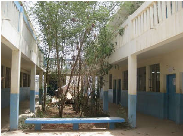
写真 15: Dogley 中学校。無償資金協力「基礎教育強化計画」により 2003 年建設。2 階建て校舎の隣棟間には中庭として整備されている。
