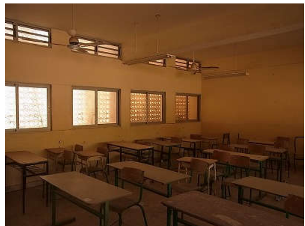
写真 6:Fukuzawa 中学校一般教室。暑さ対策として高い天井高を確保し、欄間に開口を設けて採光と通気を取っている。
