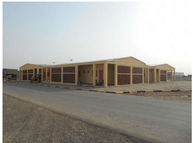
写真 9:。ナッシブ地区に複数計画されている地区マーケット。調査時点では未使用。
