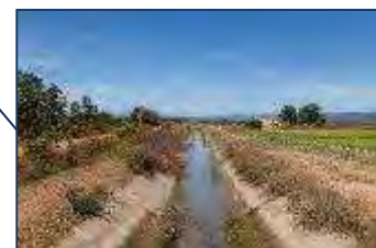
Secondary canal D14-6
