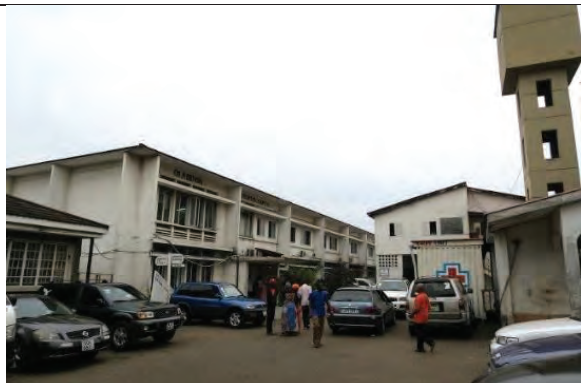
既存外観：1960年代に建設。設備は老朽化が激しいが建屋は堅牢である。
