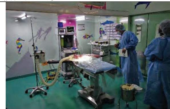
通信会社 Orange SL のサポートにより 2018 年 11 月に改修されたコノート病院の手術室。
