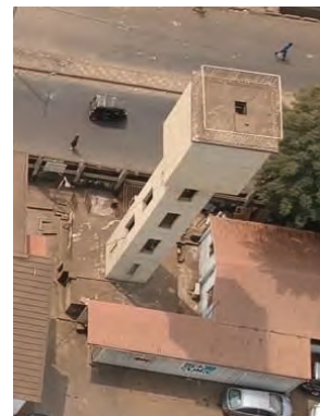
写真 2-7 敷地南東側高架水槽
