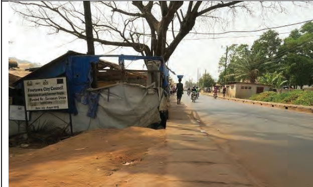
前面道路：幅員 8m の一車線相互通行。交通量が多い。道路の対面は軍人音墓地。
