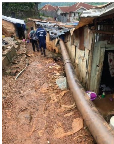
写真 2-14 給水本管の敷設状況
