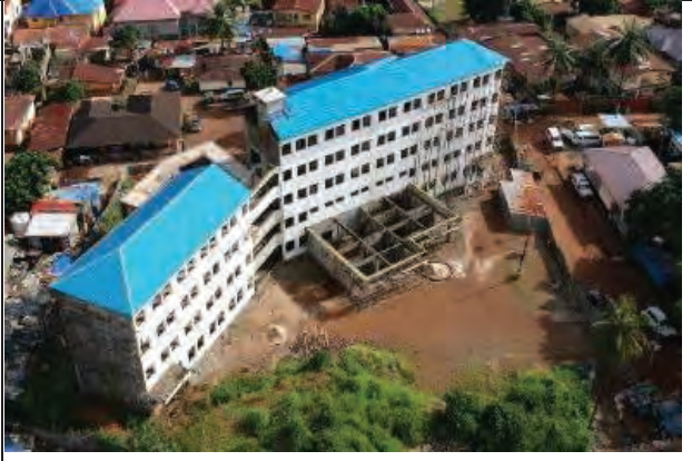
建設中の新ラムリー二次病院：2016 年末に着工するも未完成。総合病院であり小児病床含む計 85 床。
