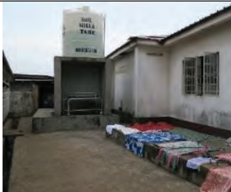
給水タンク・浄化槽：各塔屋に給水タンクと浄化槽を設置。断水が多く十分機能していない。
