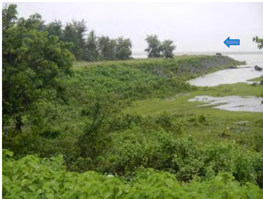
図 22 河岸に設置されている水制① 左岸堤防より撮影。上図のような水制が途切れることなく両岸に連続して設置されている。
