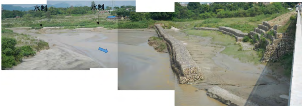
図 18 鉄線籠による 2 重に設置された護岸、及び鉄線籠による水制 東西ハイウェイ橋梁上より撮影。同ハイウェイの橋梁の取付道路盛土の水衝部に護岸が設置されており、さらにその上流にも鉄線籠による水制が設置されている。
