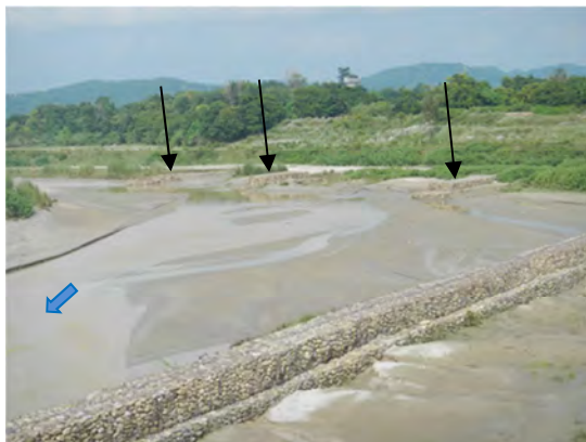
図 19 3 基の 2 段積み水制 上流左岸に建設されており、1 段目は堆砂に埋まっている。
