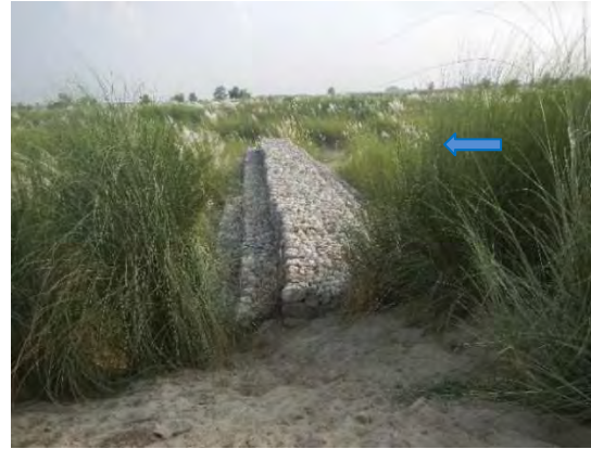
図8 鉄線籠で造られた水制② 破堤箇所の上流側に設置されている。
