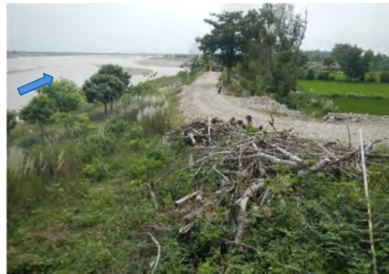
図 17 上昇した河床 堤防 (写真中央) を挟み、農地 (写真右側) より河床 (写真左側) が上昇している。
