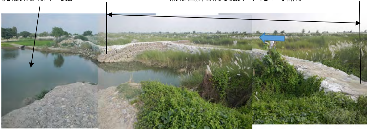
図 6 補修中の下流左岸堤防 橋梁の下流左岸堤防部分が 2019 年 7 月の洪水で越流して破堤した。土嚢と鉄線籠で補修されている。
