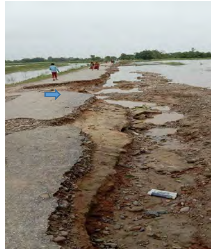
図 3 Bagmati ~Aruwa における盛土と舗装の被災（Rautahat）
