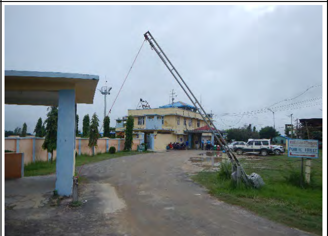
第一次現地調査（ジャナクプル空港） （2019/09/26）
