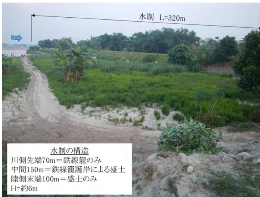
図 14 右岸に建設された水制
