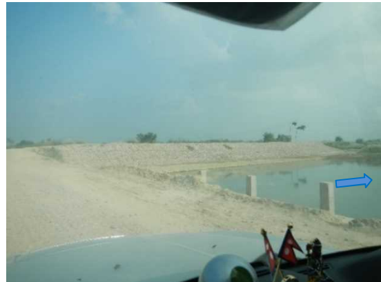
図 5 鉄線籠で造られた護岸② 橋梁取付道路から撮影。
