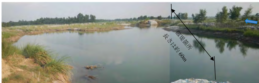
図11 補修中の左岸堤防 2019年7月に洪水越流によって、Rauthat districtのKarniya村付近の左岸堤防が50mにわたって決壊したため、土囊とネットで補修中。
