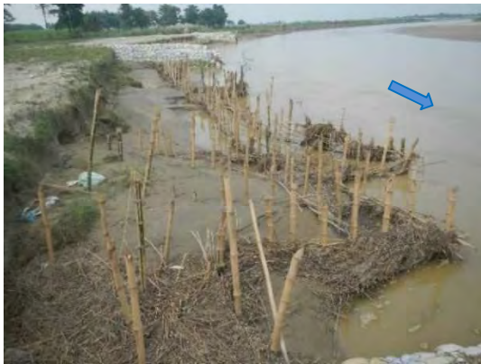
図 4 水制の間に設置された竹と粗朶 水制の間には土砂が堆積しており、河岸侵食対策の機能を果たしている。
