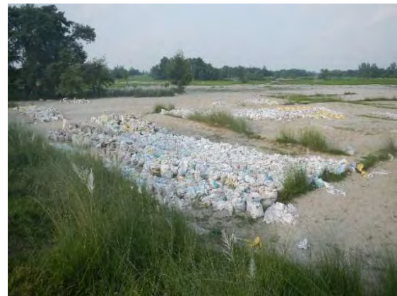
図10 準備中の土囊 決壊した堤防箇所(図11)を補修するために準備されている。
