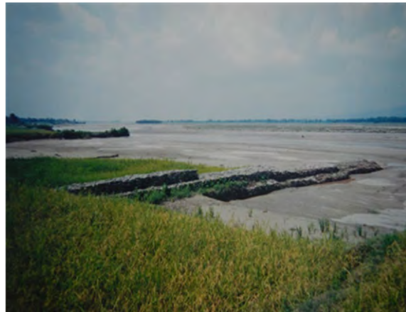
図 1-10 ラカンディ川に設置された鉄線籠の水制
