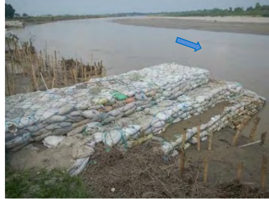
図 3 土嚢とネットによる水制 水制により河岸は侵食から守られている。鉄線籠工の玉石が不足しており、代替材として耐紫外線土嚢が使用されている。
