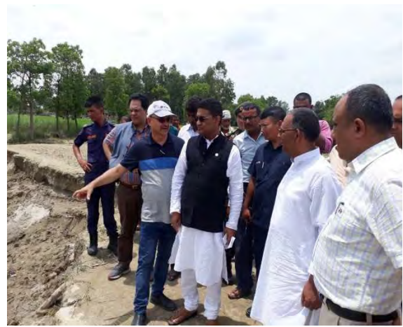
図 7 Bagamati ~ Aruwa における舗装の被災②
