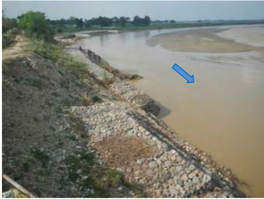
図 2 鉄線籠で造られた護岸① 橋梁の上流河岸は護岸によって侵食から守られている。
