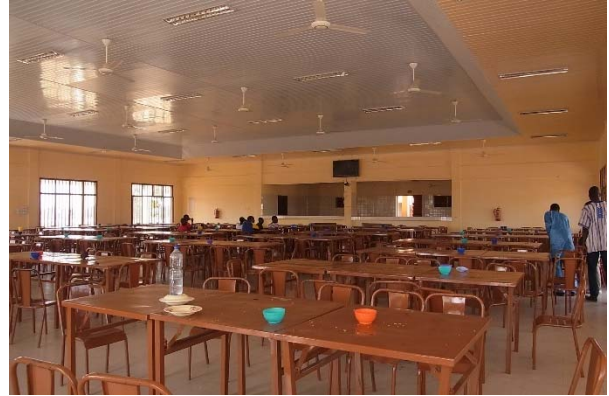
写真7. 類似校（ENEPテンコドゴ）：食堂 奨学生（寮生）が利用する食堂。厨房の熱源にはガ スを使用している。本計画で消防に指導を受けた、 排煙設備は未整備。
