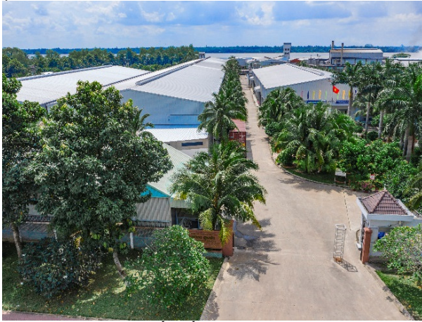
Nhà máy chế biến dừa (quy mô: 5 ha) (Công ty TNHH Dừa Lương Quới)
