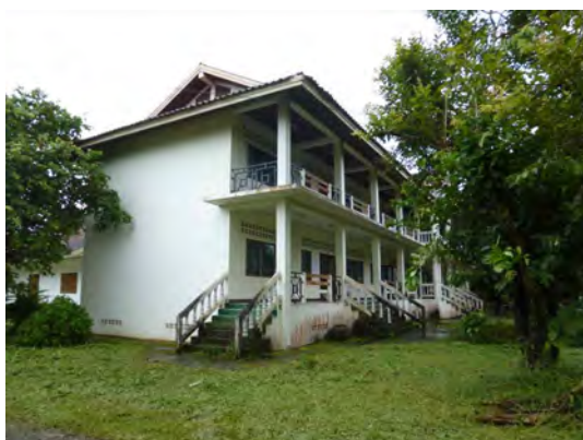
2 階建て TTC 教室棟：構造上の問題はみられず、継続使用が可能である。
