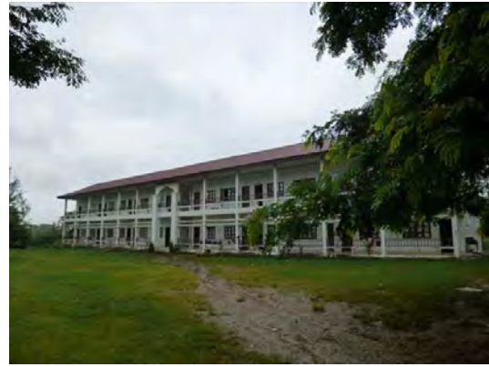
女子学生寮：2014年に政府が建設した2階建て学生寮。
