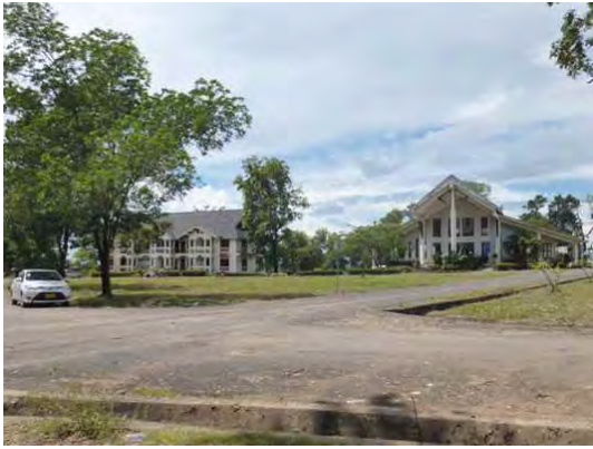
事務棟(左)、図書館(右)：建設後約 20 年経過しているが、良く維持管理されている。
