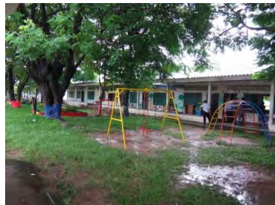
TTC 教室棟兼付属幼稚園：付属幼稚園の教室不足により、5教室中2教室を付属幼稚園、3教室を初等教員養成用教室として使用している。
