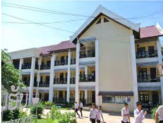
付属中学校：近年竣工した3階建て普通教室棟。
