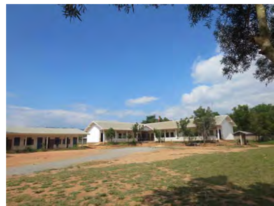
付属小学校（飛び地）：近隣協力校を付属校化した。9教室あるが、教室サイズは基準以下である。
