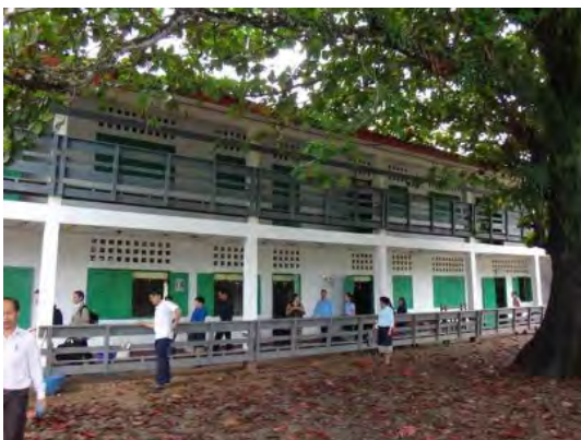
附属小学校：2階建て教室棟（5教室）。床レベルが低いため、浸水被害を受けやすい。2018年のダム放流による洪水では、複数回にわたって床上浸水被害を受けた。
