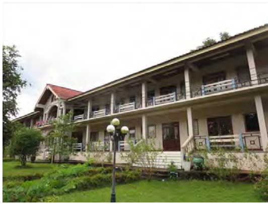
TTC 教室棟：2階建て教室棟は維持管理されており、継続使用可能である。
