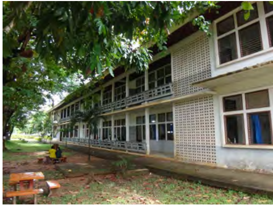
TTC 教室棟：建設後約 50 年が経過するが、維持管理されており、継続使用可能な状態にある。
