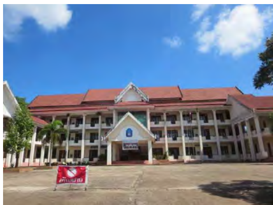
教室棟：ベトナムの支援により建設され、中高一貫校として運営している。
