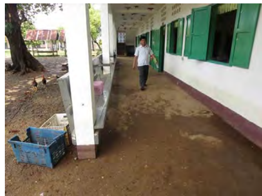
附属小学校：2階建て教室棟（5教室）。床レベルが低いため、浸水被害を受けやすい。2018年のダム放流による洪水では、複数回にわたって床上浸水被害を受けた。
