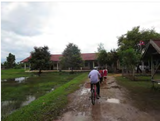
附属中学校：建物周囲、運動場は水はけが悪く、雨季には浸水しがちである。
