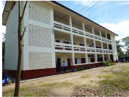
TTC 教室棟：2016 年に政府資金で建設された 3 階建て教室棟。
