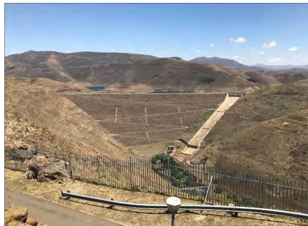
Mohale ダム全景
