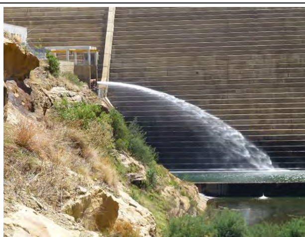
Metolong ダム維持放流の様子
