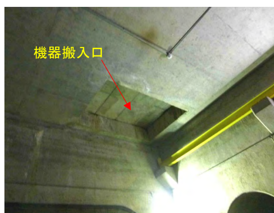
図 5-4.4 発電設備建屋の機材搬入口
