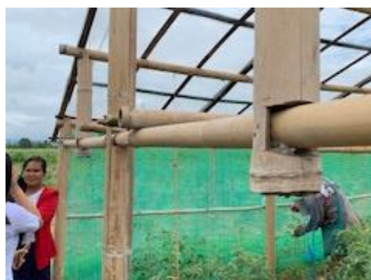
竹の組み方しだいで、雨除けハウスの強度が増す。これも重要なノウハウ。
