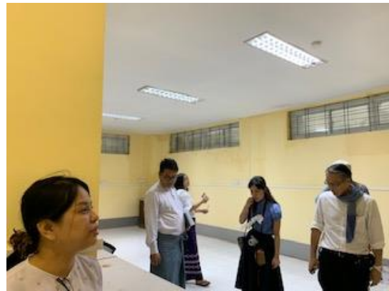
(新ラボ) 設計が事務所仕様で実験室仕様になっていない
