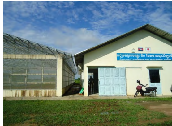
在カンボジア日本大使館の草の根無償で建設されたキャッサバセンター建物（UBB農場内）
