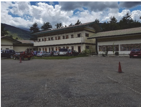
写 1 1 AMC トレーニングセンター。オペレータに操作・メンテナンスの教育を行う。
