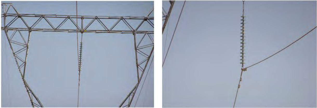
図 3-4.4 既設 220kV 1 回線送電線上部状況（アークホーンなし）
