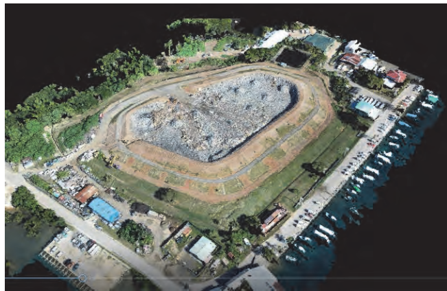
図 2-14 パラオ M-Dock 最終処分場
