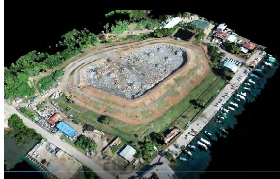
パラオ M-Dock最終処分場
