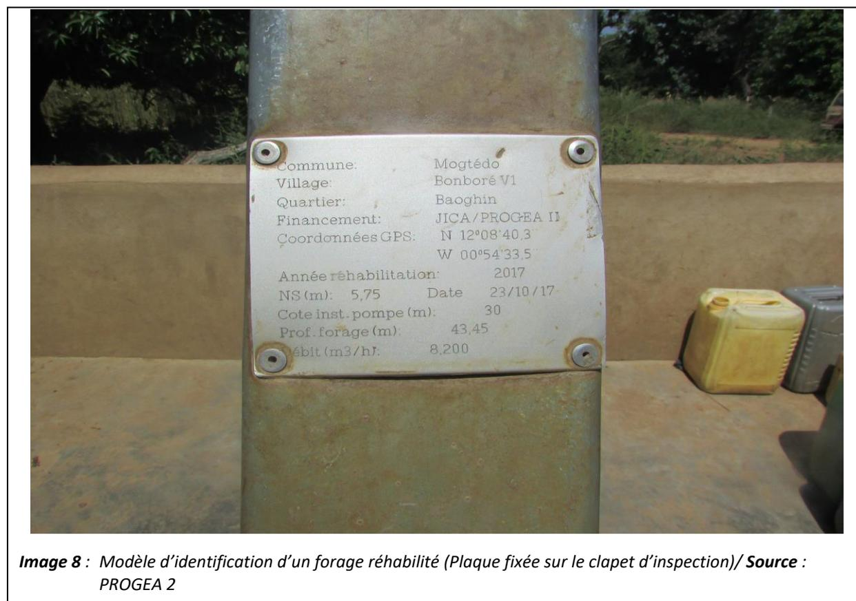
**Image 8 :** Modèle d'identification d'un forage réhabilité (Plaque fixée sur le clapet d'inspection)/ **Source :** PROGEA 2
