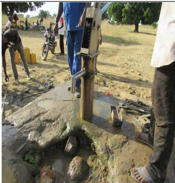
**Image 1 :** Dépose en cours d'une pompe/ Source : PROGEA 2
