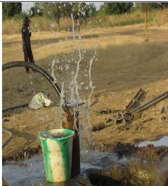
**Image 2 :** Fin de la dépose de la pompe et début de soufflage/ Source : PROGEA 2
