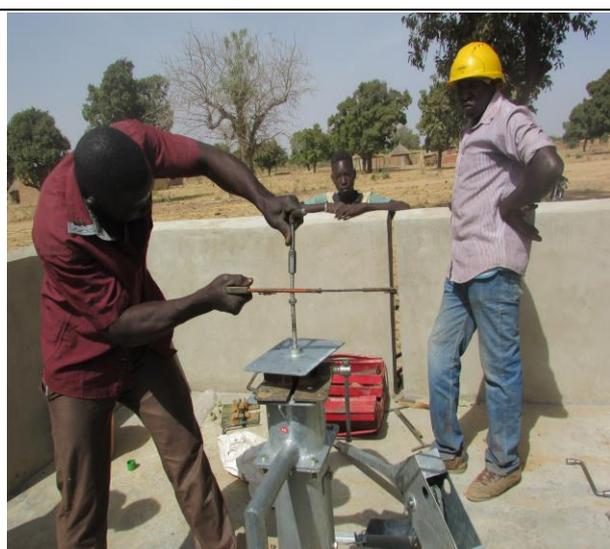
**Image 6 : Installation d'une nouvelle pompe/ Source : PROGEA 2**
