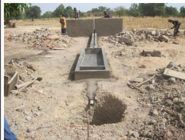
井戸改修工事の様子 付帯施設の建設（2017年11月）
