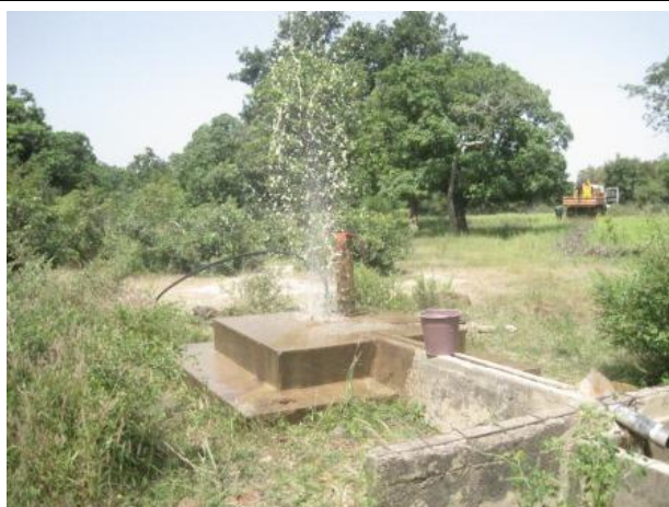
井戸改修工事の様子 エアリフトによる井戸からの地下水吹き上げ状況 (2017 年 10 月)
