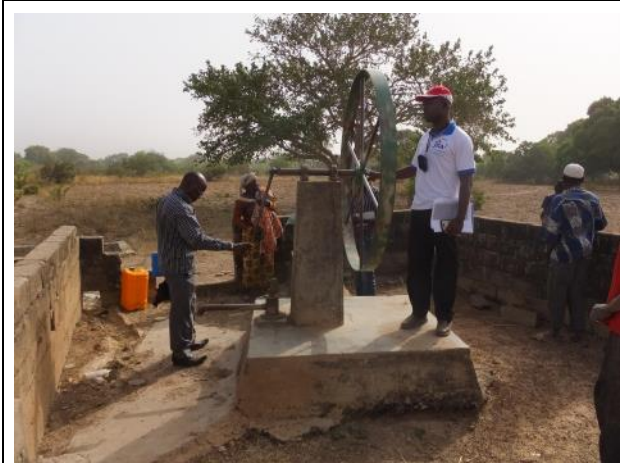
井戸改修工事前の井戸診断調査 (2016 年 12 月 27 日、 ナウリ県 Pô コミューン Tiakané 村)
