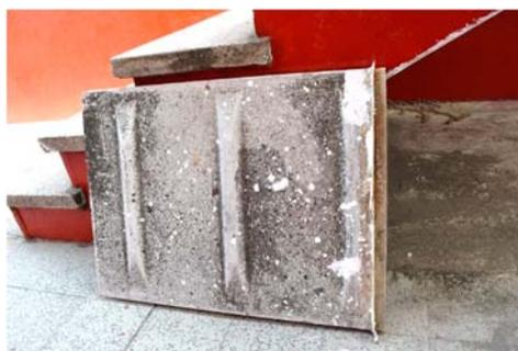
風で飛ばされたカバー、接合ネジ部が壊れている
