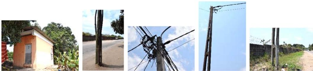
変電設備 → 電柱から地下へ → 地下から電柱 → レーダー局舎直近の電柱 → 地下ケーブルで局舎敷地内へ
