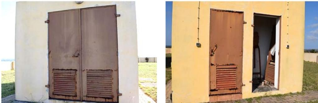
レーダー室及びE・G室の扉は錆による腐食、部分破損が著しい
