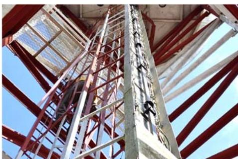
ラダー上部のカバー破損している
