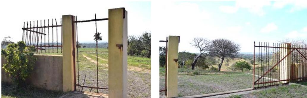
局舎入り口の門：鉄材部分は錆による腐食破損で門としての機能は失われている
