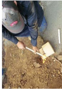
Foto 1: Imagen del calentamiento del tubo PVC a fuego directo
