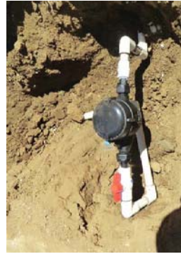
Foto 2: Instalación del medidor y tubos con codos
