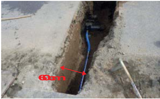
Figura N° 9. Ancho de excavación estándar.
