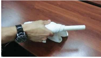
Figura N° 18. Limpieza del tubo de conexión domiciliaria.
