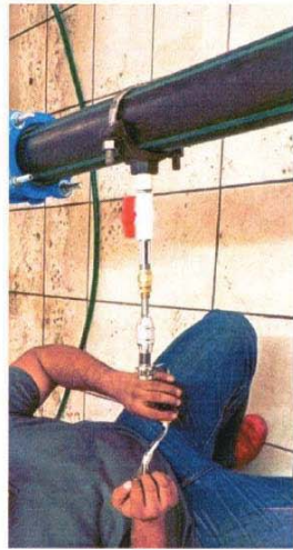
Figura N° 16. Herramienta de perforación (taladro de mano).
