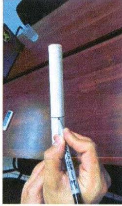
Figura N° 19. Marcado del tubo de conexión domiciliaria.
