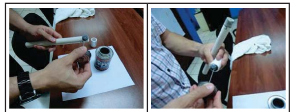
Figura N° 25. Aplicación de pegamento para PVC.
