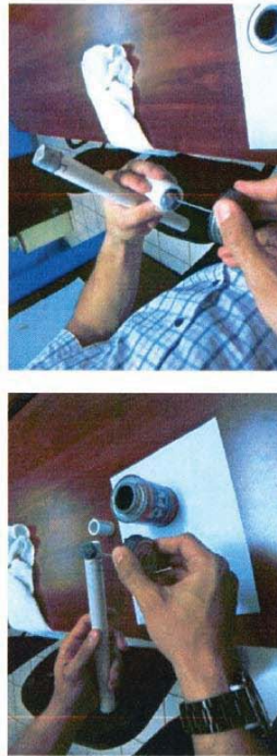
Figura N° 25. Aplicación de pegamento para PVC.
