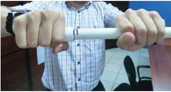
Figura N° 26. Mantenimiento del tubo de PVC después de la conexión.
