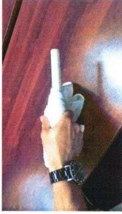
Figura N° 18. Limpieza del tubo de conexión domiciliaria.
