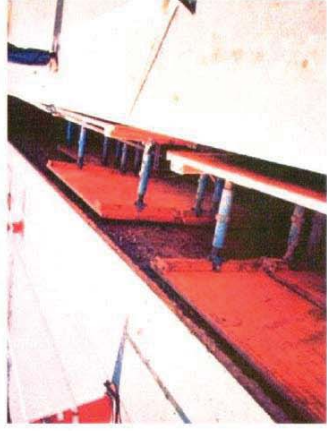
Figura N° 11. Trabajo de muro de contención.
