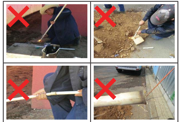
Figura N° 32. Conexión de los tubos calentando el tubo de PVC.
