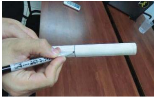
Figura N° 19. Marcado del tubo de conexión domiciliaria.
