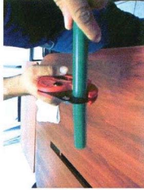
Figura N° 23. Corte del tubo de conexión domiciliaria (polietileno).
