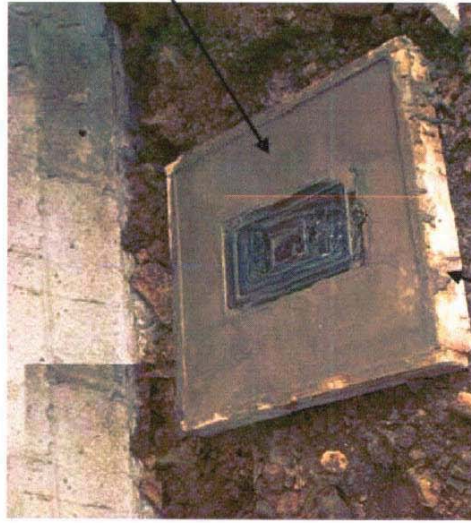
Figura N° 37. Ubicación de medidor.
