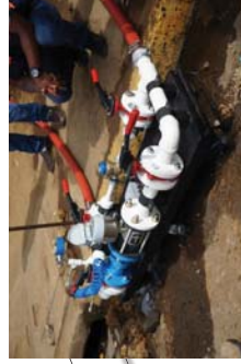
Medidor casero combinando 2 caudalímetros
