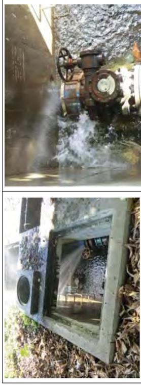
Foto 5.1 Fugas de válvulas en el tanque de Altamira
