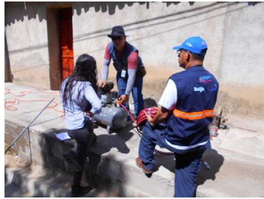
P-14 空気注入による漏水探知
