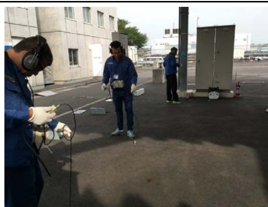
P-16 漏水探知機器の種類と操作の研修
