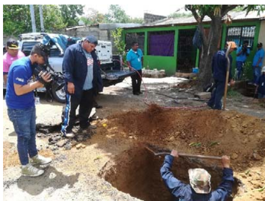
P-11 推進工法による給水管敷設
