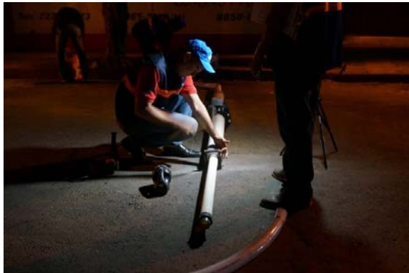
P-57 損失水量直接測定
