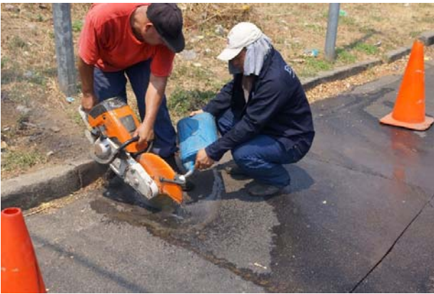
P-21 アスファルト舗装の切断
