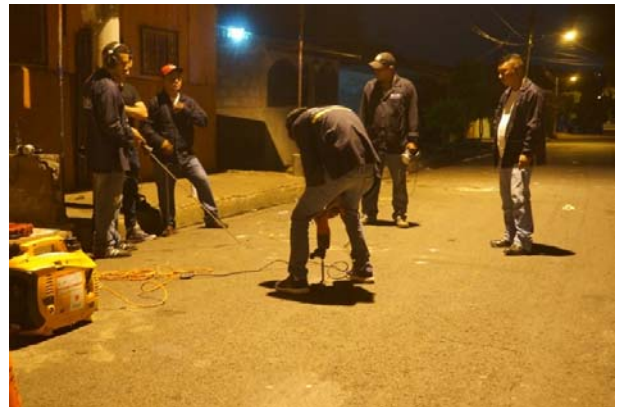
P-50 夜間の損失水量直接測定
