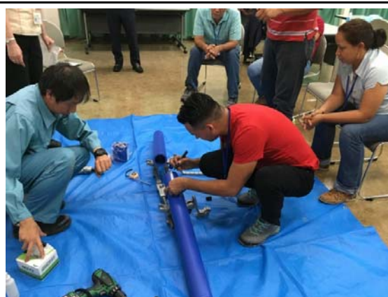
P-15 ポリエチレン管の接合技術研修
