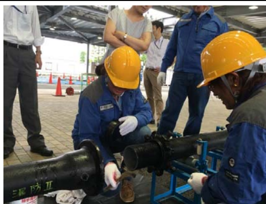
P-14 鋳鉄管の接合技術の研修
