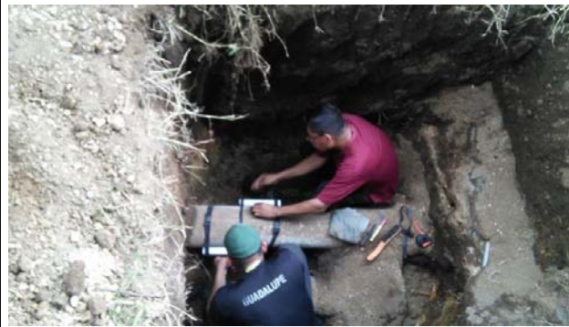
P-42 配水池の流量測定
