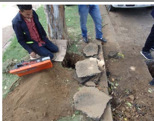
P-40 パイロット区画の管路位置の調査
