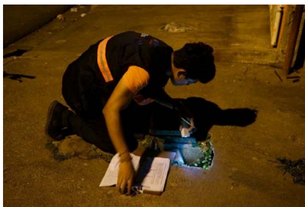
P-26 MS61 サブセクター1の漏水量直接測定
