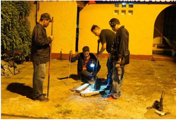
P-49 夜間の損失水量直接測定
