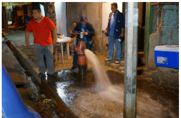
P-24 配水管の排水作業
