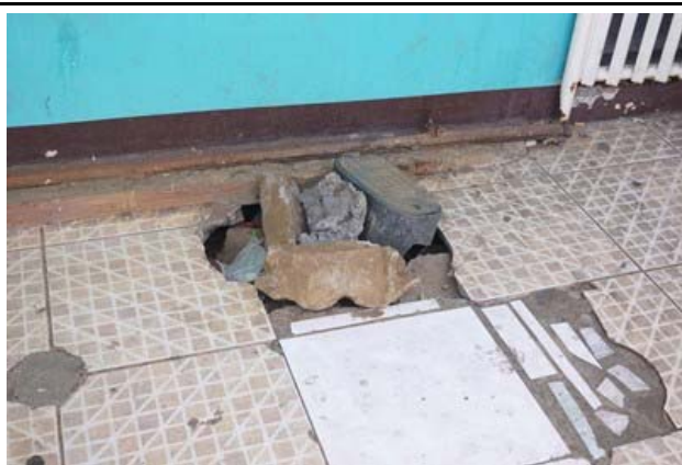
P-27 水道メータが撤去された状態
