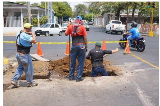
P-22 バルブ設置のための掘削
