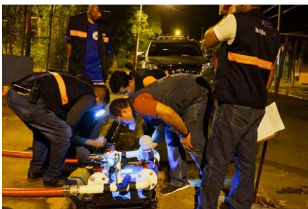
P-25 MS61 サブセクター1の漏水量直接測定
