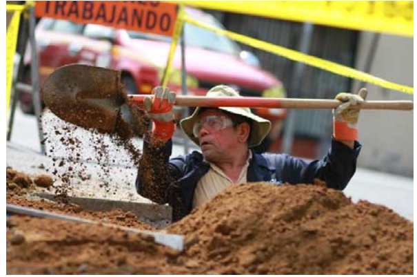
P-20 パイロット区画のバルブ工事
