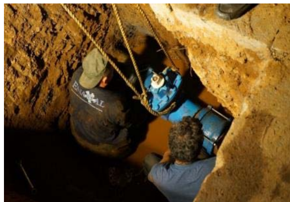
P-23 バルブ据付
