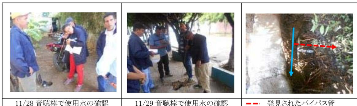
写真 3.6 非合法接続の探知作業の様子
