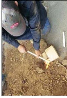
写真 1 火炙りによる PVC 管の接続作業
