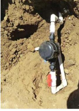
写真2 水道メーターと曲管の設置
