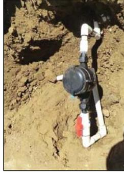
写真 2 水道メータと曲管の不適切な配置
