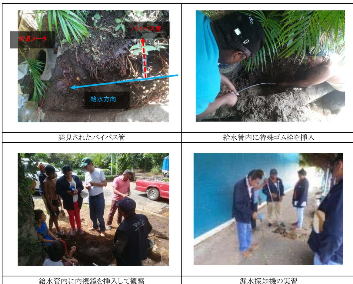
写真 3.7 非合法接続の探知作業の様子
