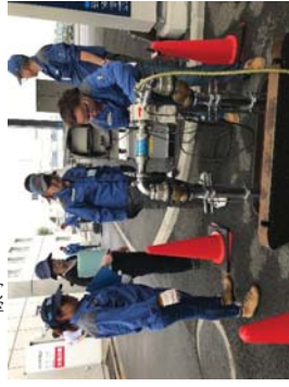
写真14: 水道配水用ポリエチレン管の接合技術の様子
