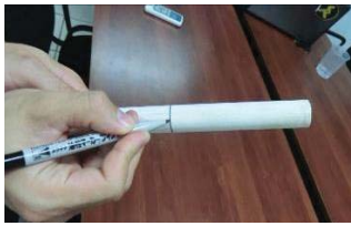
Figura N° 19. Marcado del tubo de conexión domiciliaria.
