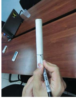
図 19 給水管のマーキング
