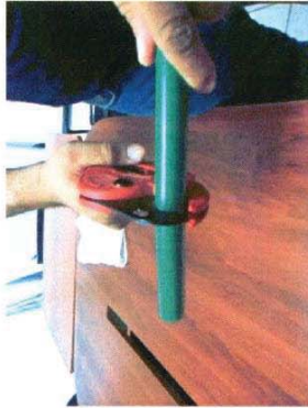
Figura N° 23. Corte del tubo de conexión domiciliaria (polietileno).
