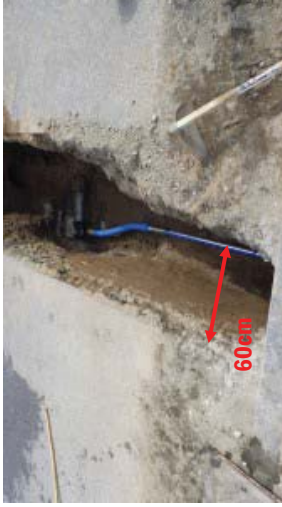
図9 標準掘削幅
