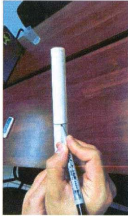
Figura N° 19. Marcado del tubo de conexión domiciliaria.
