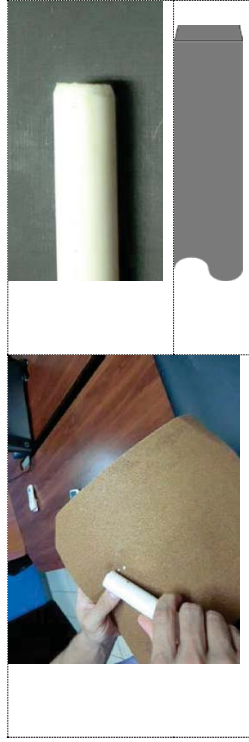
図 21 給水管 (PVC) の切断
