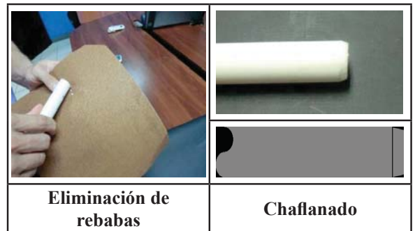
Figura N° 22. Eliminación de rebabas y chaflanado del tubo de conexión domiciliaria (PVC).
