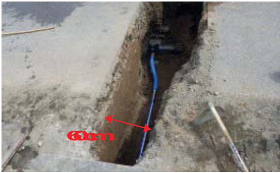
Figura N° 9. Ancho de excavación estándar.
