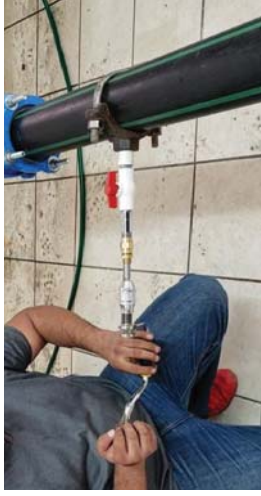
図 16 穿孔専用工具（手動ハンドドリル）
