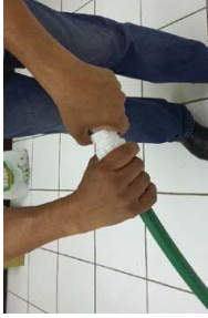
人力による締め付け
