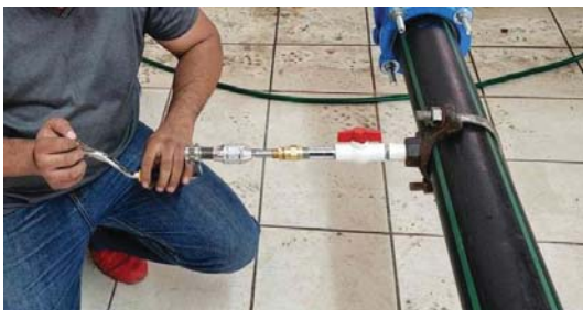
Figura N° 16. Herramienta de perforación (taladro de mano).
