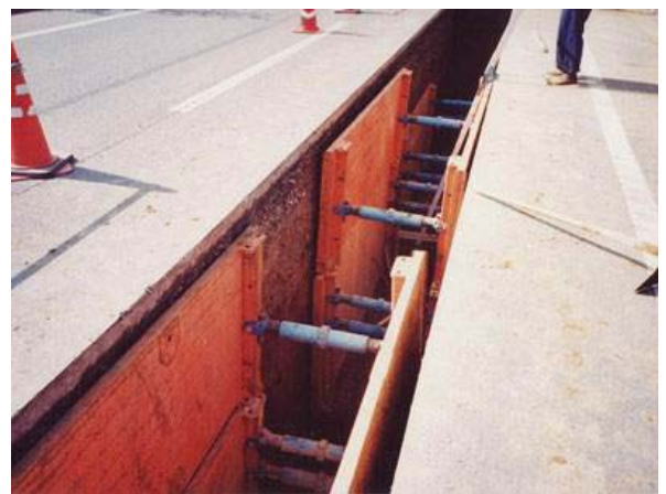
Figura N° 11. Trabajo de muro de contención.
