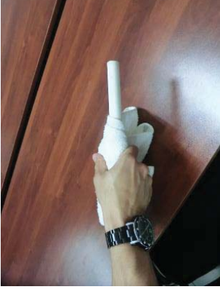
図 18 給水管の掃除
