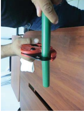
図 23 給水管 (ポリエチレン) の切断
