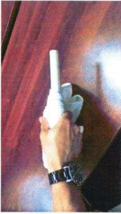
Figura N° 18. Limpieza del tubo de conexión domiciliaria.
