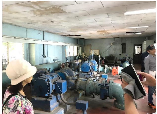
現場視察 アソソスカ ポンプ場 (12月18日)
