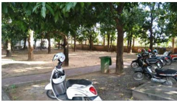
写真-3：タクマウ浄水場浄水施設の建設予定地 PPWSA の料金徴収所の敷地内の浄水施設の建設予定地である。
