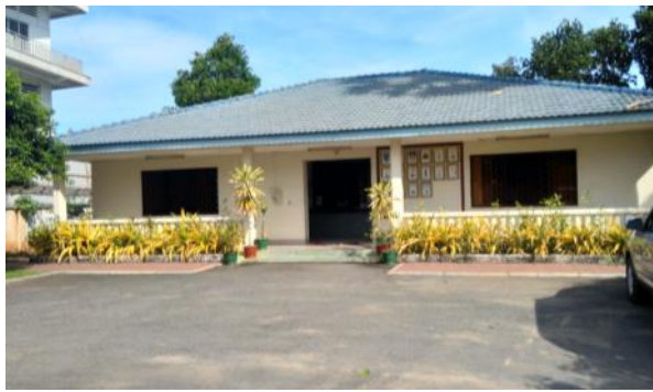
写真-1：タクマウ浄水場建設予定地の現状 浄水場建設予定地は、PPWSA の料金徴収所として利用されており、タクマウ浄水場の建設のため PPWSA により建設開始までに移設される予定である。
