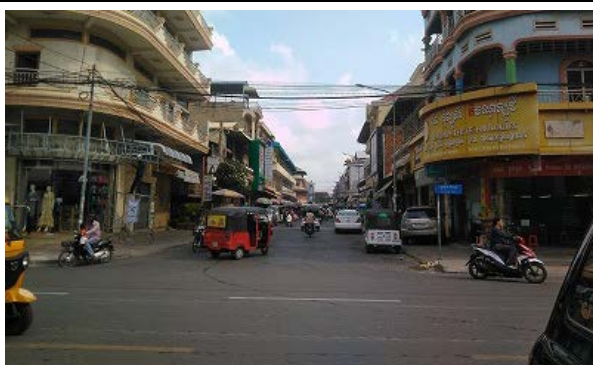
写真-5：タクマウ市中心街の現状 タクマウ市の中心街の状況である。給水接続及び管路工事は PPWSA により実施されることとなっている。
