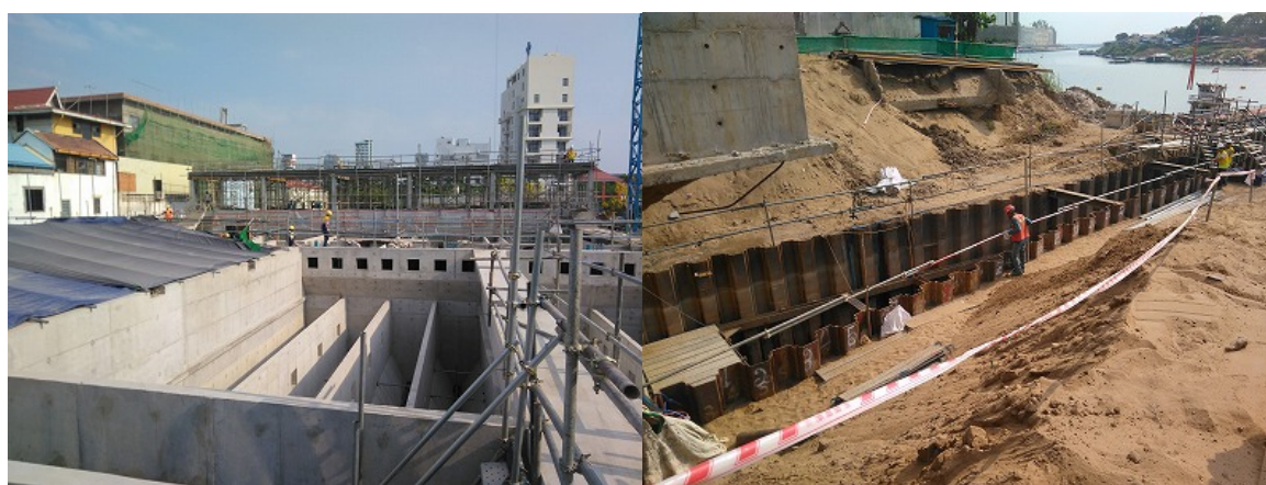
浄水場建設状況
