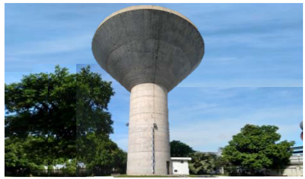
写真-2：タクマウ浄水場建設予定地の現状 料金徴収所敷地内に建設されている高架水槽で、タクマウ市への配水に利用されている。
