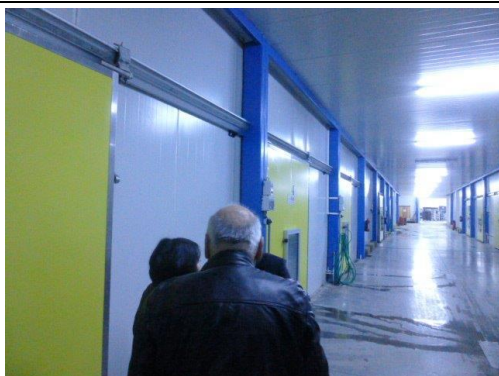
ケペズ本社工場内にある冷蔵倉庫施設
