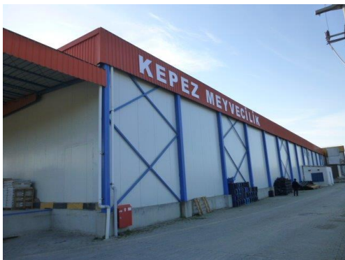
ケペズ 社本社（兼作業工場施設）
