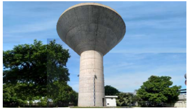
写真-2：タクマウ浄水場建設予定地の現状 料金徴収所敷地内に建設されている高架水槽で、タクマウ市への配水に利用されている。
