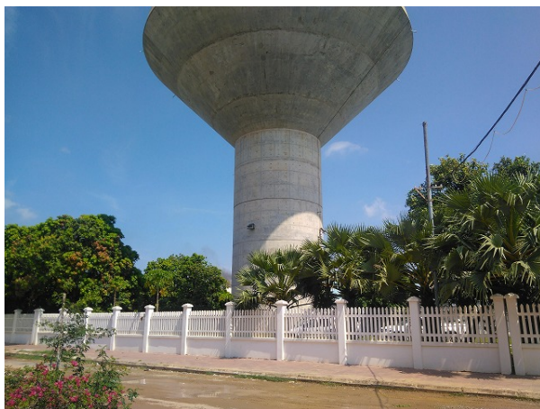
タクマウ高架水槽の状況
