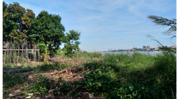
写真-4：タクマウ浄水場取水施設の建設予定地 バサック川に面したタクマウ浄水場取水施設の建設予定地である。
