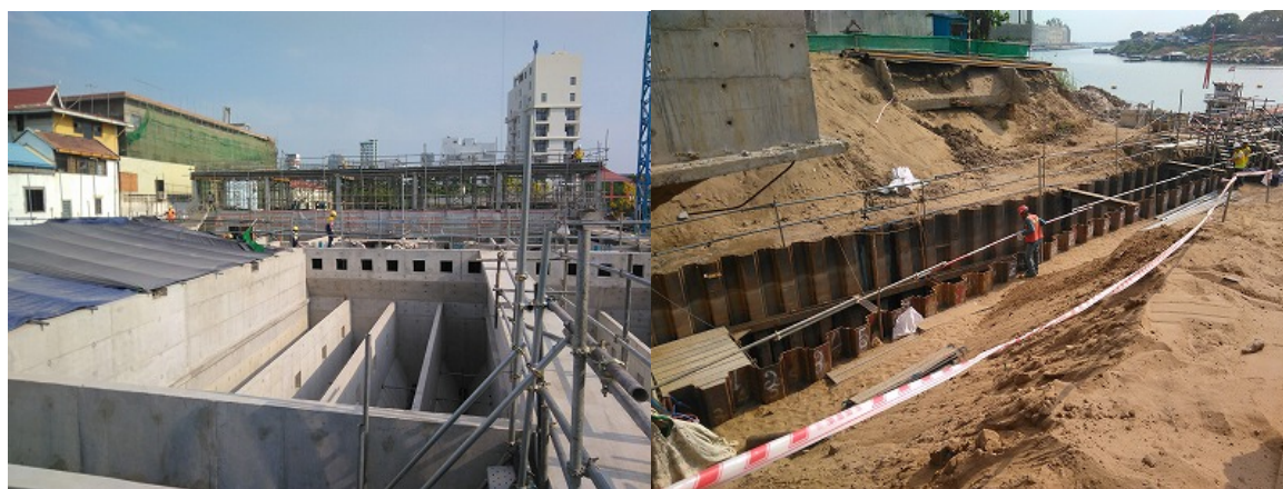
浄水場建設状況
