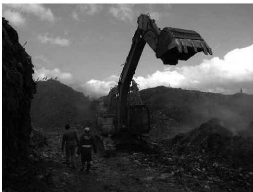
バックホウによる場内の整地作業
