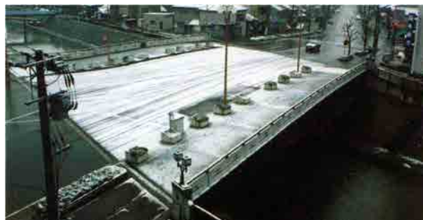
Джерело: Зменшення замерзання поверхні сталевого перекриття шляхом додавання матеріалу для зберігання тепла Рисунок 7-10-1. Стан замерзання мостового покриття з використанням сталевого перекриття
