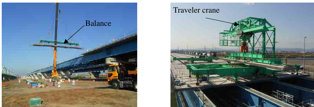
図 12-3-3 クレーン（左側）および桁上走行クレーン（右側）による架設
