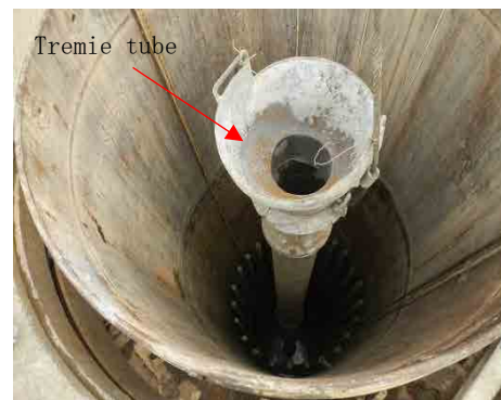
図11-2-15.場所打ち杭のコンクリート打設状況参考図
