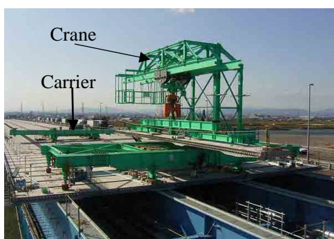
図 11-2-23.走行クレーンによる架設参考図
