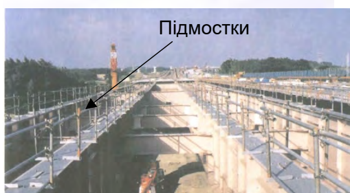
Рисунок 12-3-5. Підмостки на сталевих балках
