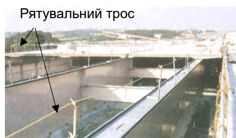
Рисунок 12-3-6. Рятувальний трос для будівельних робіт
