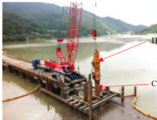
Рисунок 11-2-7. Метод будівництва підвісним занурювачем
