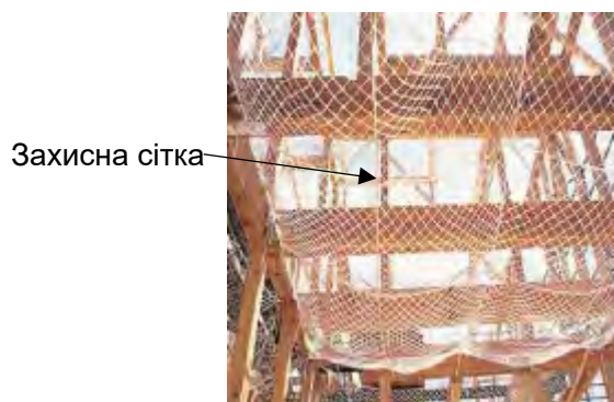
Джерело: Головна сторінка Tanaka Steel Рисунок 12-3-7. Захисна сітка під сталюю балкою
