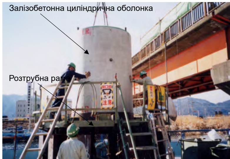
Рисунок 12-3-1. Встановлення залізобетонної частини
