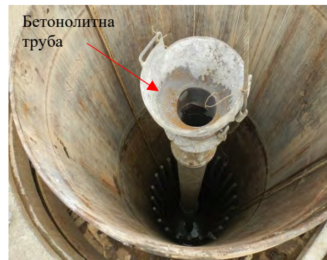
Рисунок 11-2-15. Довідкове креслення для зведення набивної палі (розміщення бетону)
