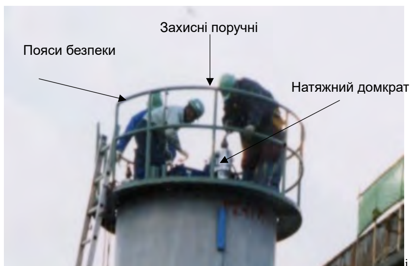
Рисунок 12-3-2. Роботи з натягування
