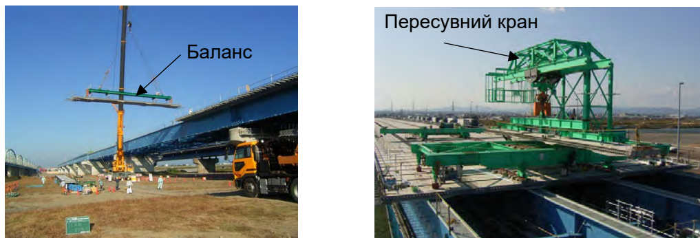
Рисунок 12-3-3. Установка Перекриття за Допомогою крана (зліва) та Установка Перекриття Поверх Головної Ферми за Допомогою Мостового Крана (справа)
