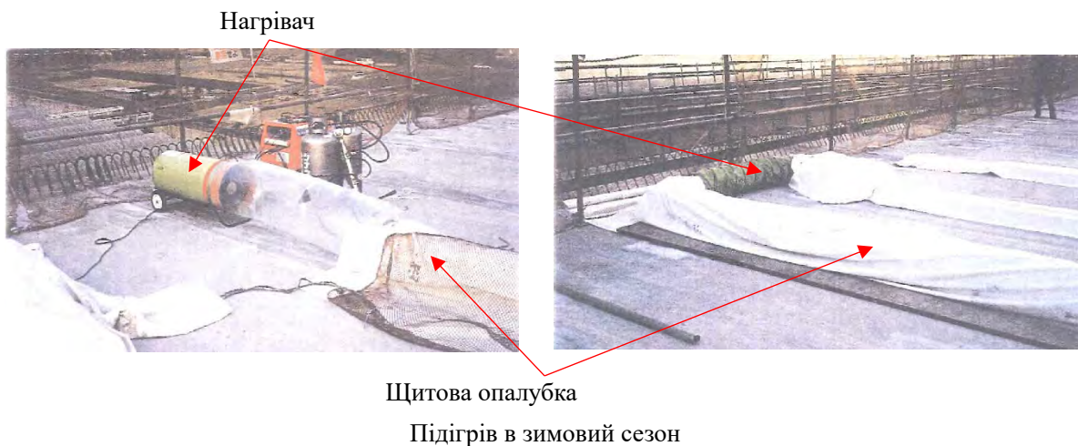
Джерело: Процедури монтажу збірної плити (березень 2004 р.) Рисунок 11-2-28. Довідкове креслення затвердіння підігріванням взимку
